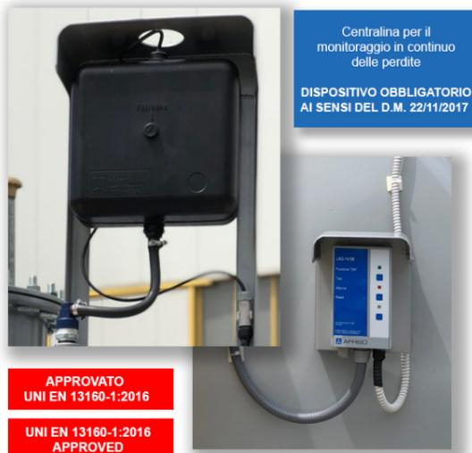
Centralina per il monitoraggio in continuo delle perdite
